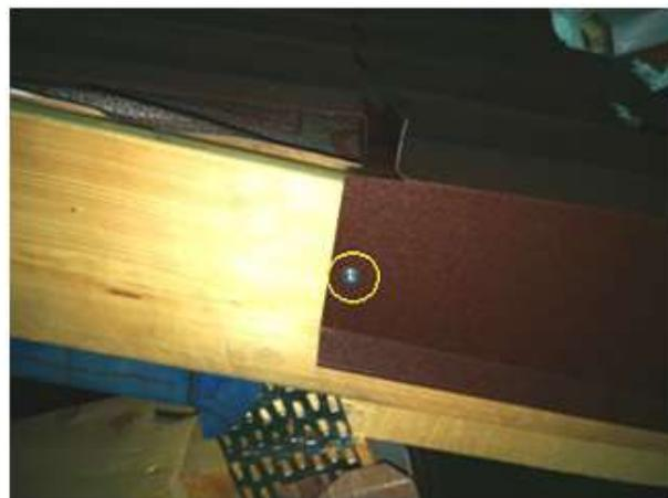
3. Закрепите планку саморезами ПШ 4,2x19 (25), в торцевую доску, внутри области ограниченной желтой окружностью. Рисунок справа вверху.
