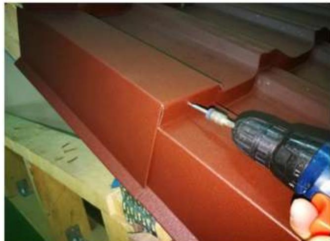
7. Зафиксируйте планку саморезом 4,8x29 или 4,8x35 в нижнюю ступеньку листа металлочерепицы. Саморез должен пройти через нижний отгиб верхней планки, верхний отгиб нижней - в ступеньку листа.
