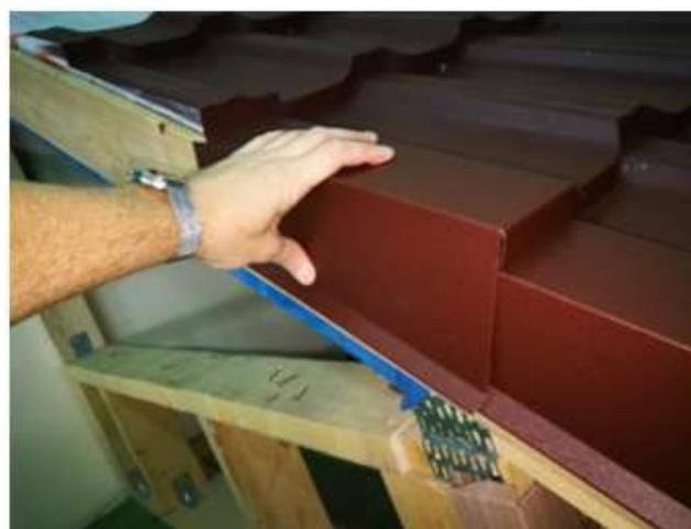
4. Следующая планка монтируется на торец второго модуля металлочерепицы, по аналогии с первой.
