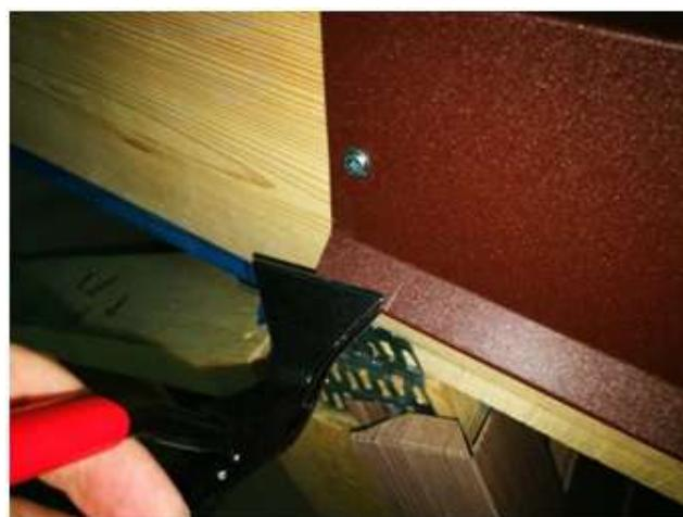
5. При простой накладке следующей планки на предыдущую между ними образуется зазор. Чтобы уменьшить зазор сожмите щипцами завальцовку на стыке планок
