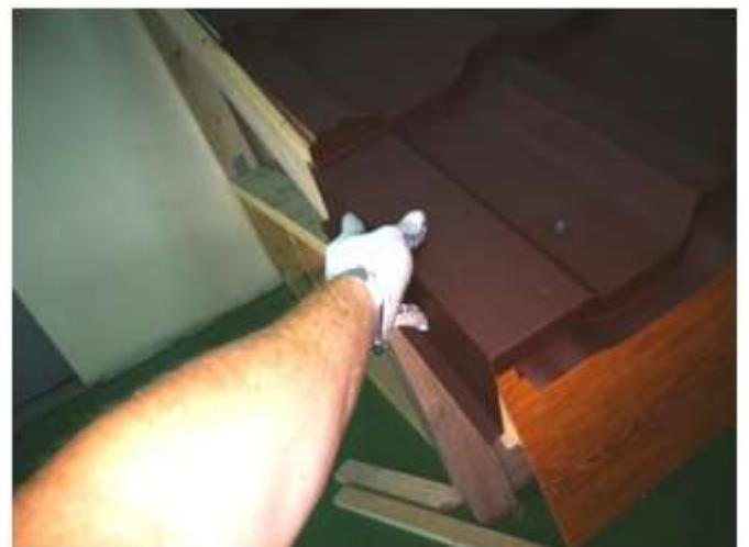
1. Установите сегментную планку на крайний нижний модуль листа на торце кровли. Плотнo прижмите боковую часть планки к торцевой доске, а нижние отгибы к первой ступени листа
