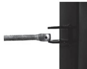
На опорный столб калитки или ворот установите откидной болт петли. Обратите внимание, что откидной болт и ось петли имеют отверстия. Отверстие откидного болта в закрытом положении должно быть обращено в сторону столба. Установите ось откидного болта с шайбами.
